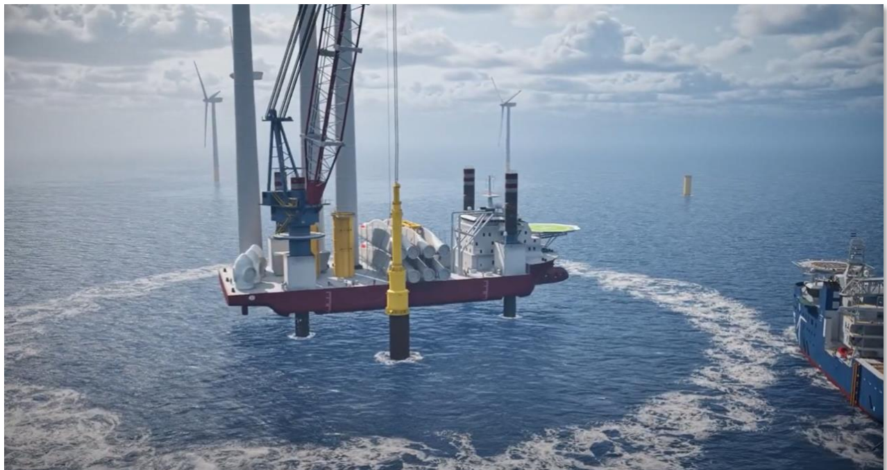
Voorbeeld van een bellenscherm rondom installatiewerkzaamheden om het onderwatergeluid te reduceren. (Bron: Topsector Energie)
